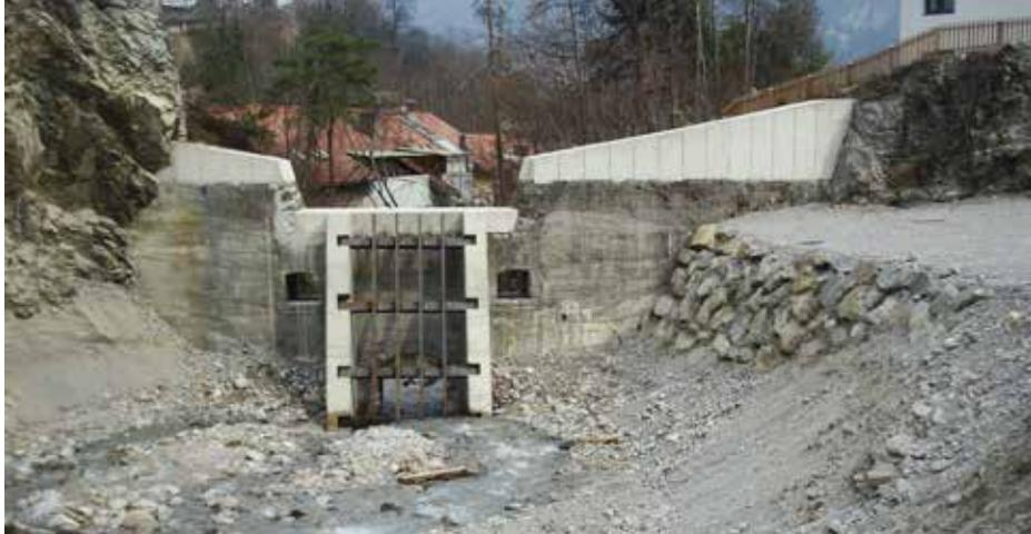
Die sanierte Stapfsperre am Malchbach ist ein wichtiger Bestandteil des Hochwasserschutzes.
